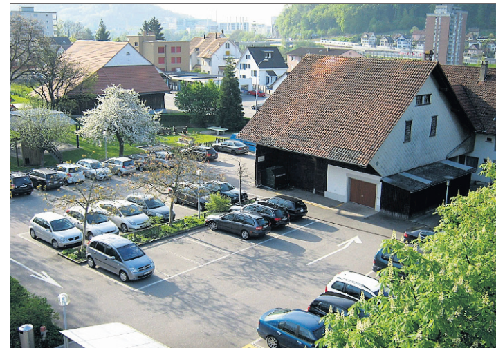
SCHLECHTER ZUSTAND Das «Strübelihus» wird abgerissen. ZVG
